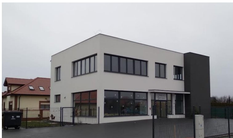
Rysunek 3. Obiekt Przedszkola Niepublicznego „Akademia Serdeczna” Zuzanna Zdunek we Wrześni. Obiekt został oddany do użytku w 2023 r. – przedszkole zlokalizowane jest w poziomie parteru.
