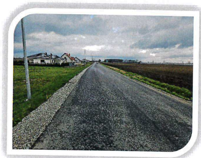
Przebudowa drogi powiatowej nr 2933P na odcinku Kokoszki - Stępcin
