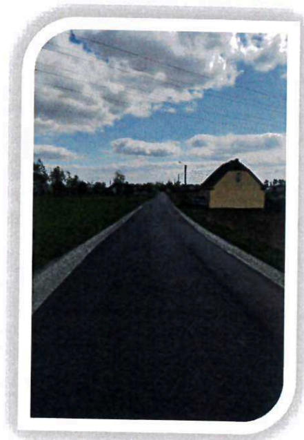
Przebudowa odcinka drogi powiatowej nr 2937P Sokołowo - Słomowo
