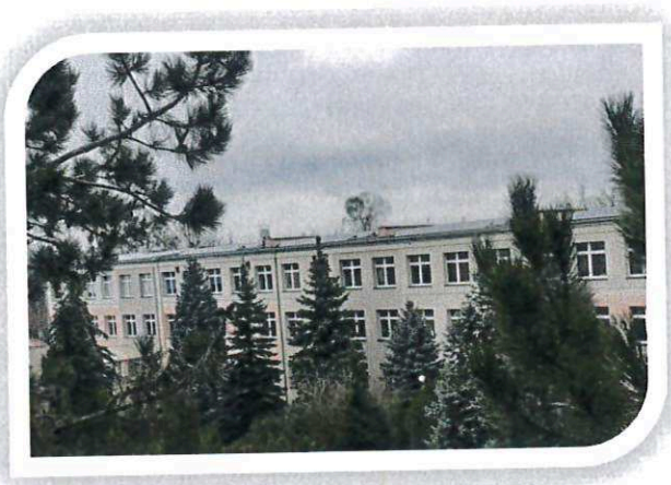
Instalacja fotowoltaiczna na budynku ZSTiO
