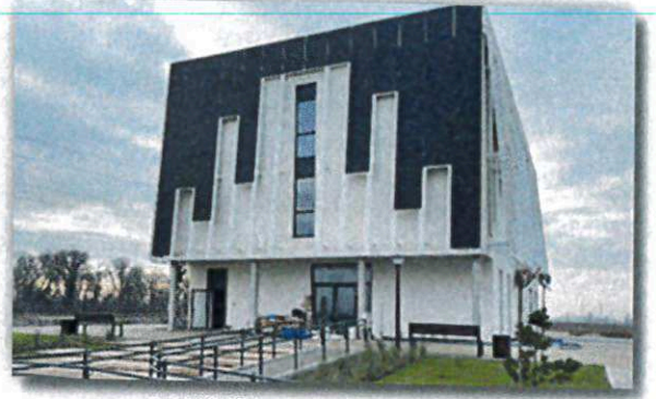
Budynek Bursy w Grzymysławicach
