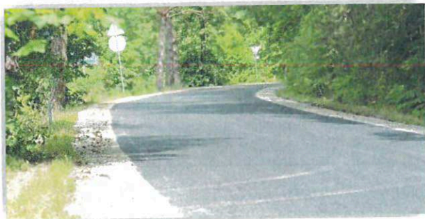
Modernizacja drogi powiatowej nr 2908P Sarnice-Mikuszewo
