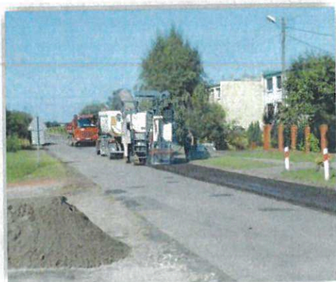
Przebudowa drogi powiatowej nr 3665P w m. Targowa Górka, ul. Średzka
